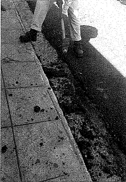
LIMPIEZA DE CUNETAS PARA QUITAR EXCESO DE MEZCLA ASFALTICA
